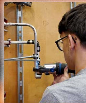
Auch die Sanitärtechnikerinnen und -techniker schaffen dauerhafte Verbindungen – ganz ohne Löten.
